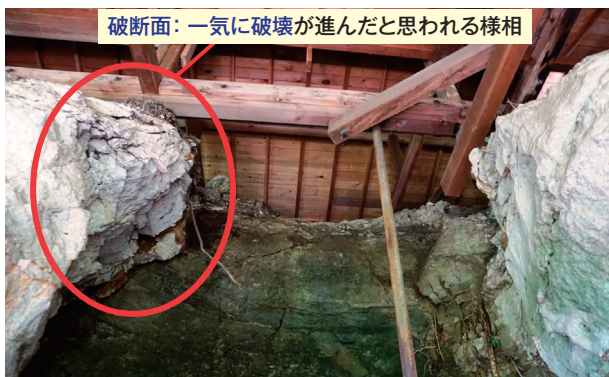
図7 破壊状況-天井落下（東窟東側奥直上）
